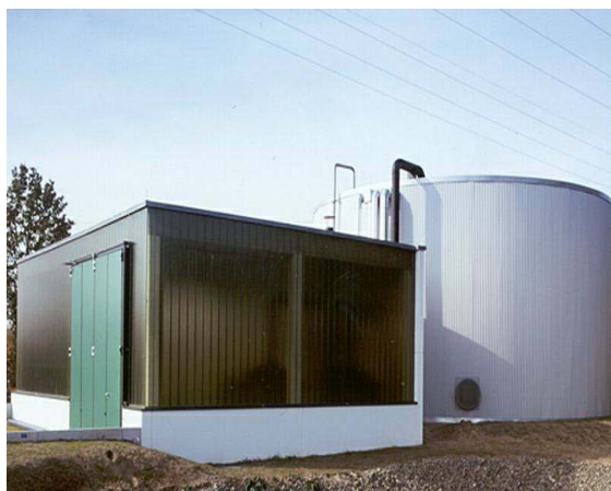
Станция нейтрализации. Общий вид очистных сооружений.
