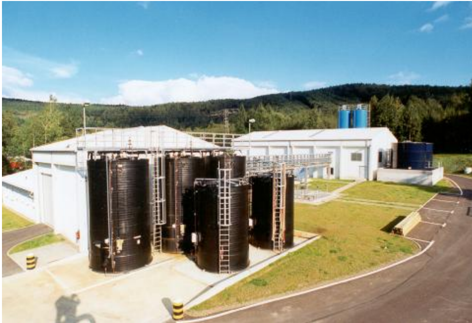
Building / Внешний вид очистных сооружений
