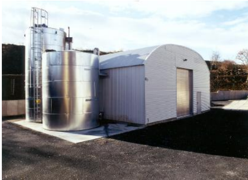
Building / Внешний вид очистных сооружений
