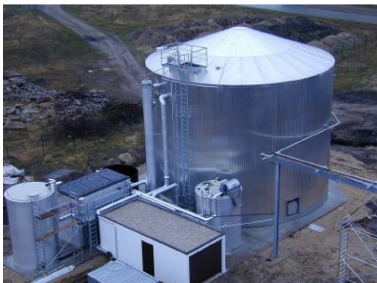
БИОМАР а очистные сооружения
