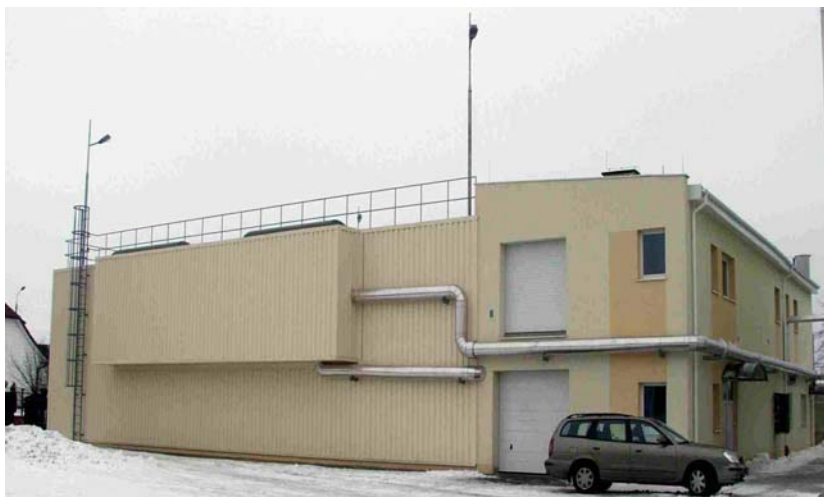
General view of the plant/Общий вид сооружений
